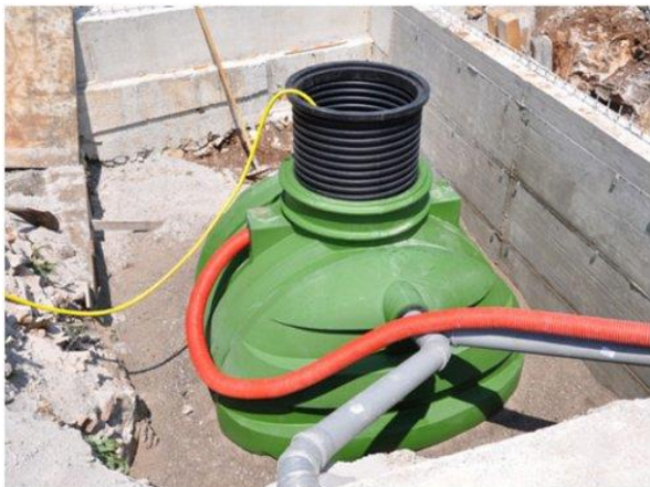
Montažna čistilna naprava iz polietilena
